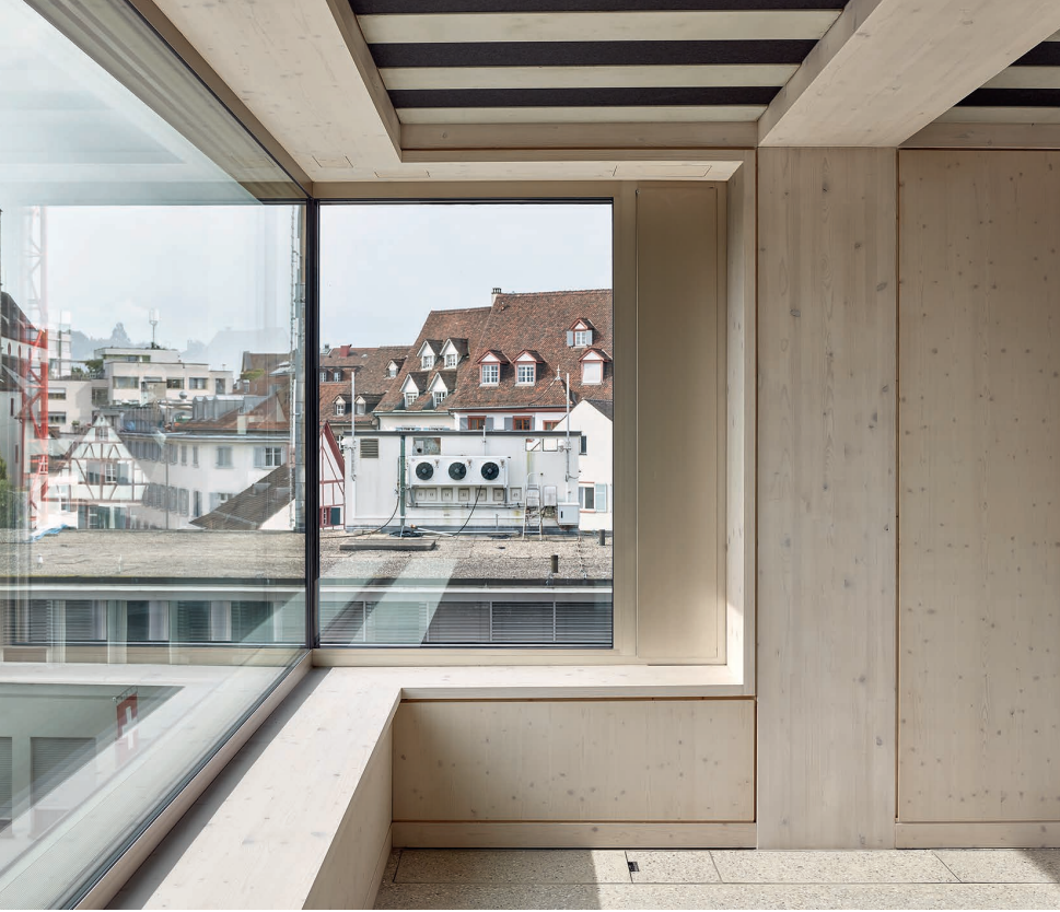
Eckfenstersituation, am Beispiel 7. Obergeschoss (Cafeteria)
