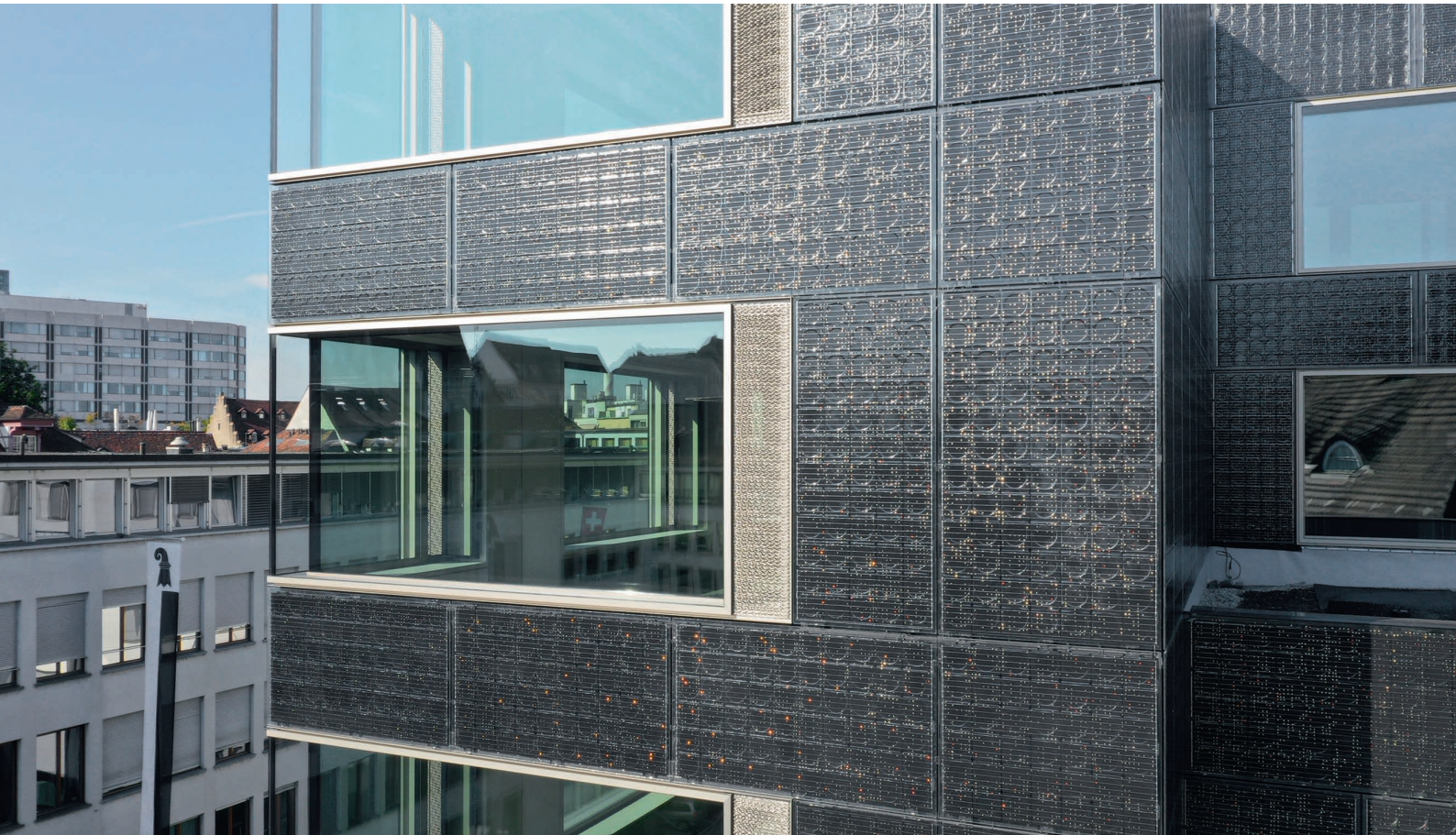
Fassade, bestückt mit Photovoltaikmodulen
