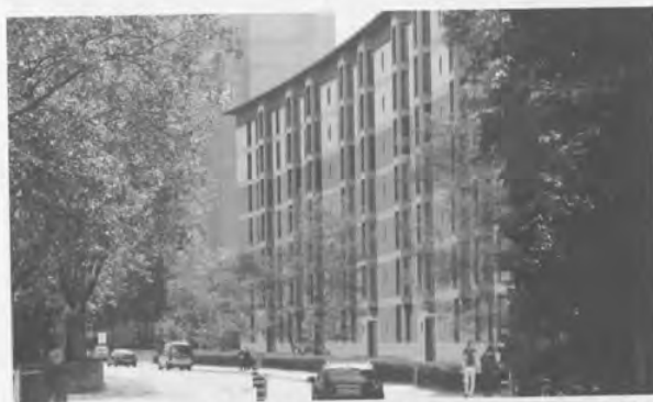
175 Erkerfassade, WB Kanzleistrasse Zürich, jessenvollenweider, 2014
