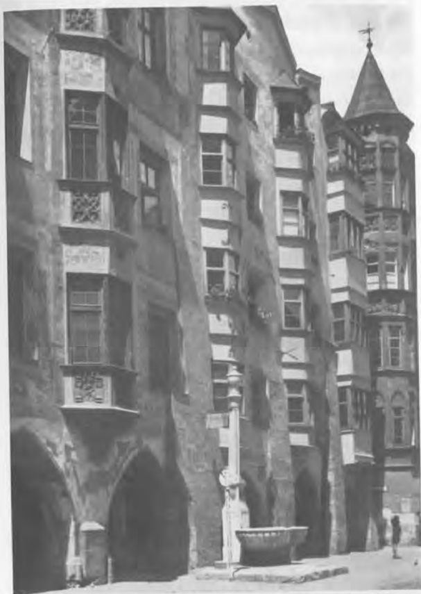
174 Mehrstockerker Hauptstrasse in Innsbruck, Tirol, um 1600
