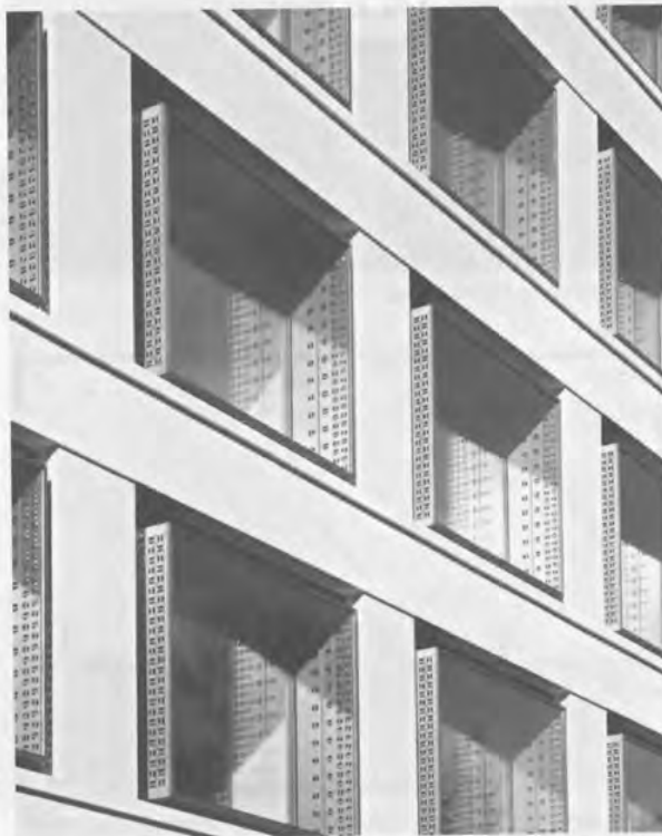
181 Kastenfenster, Verwaltungszentrum Oberer Graben, St.Gallen, 2012
