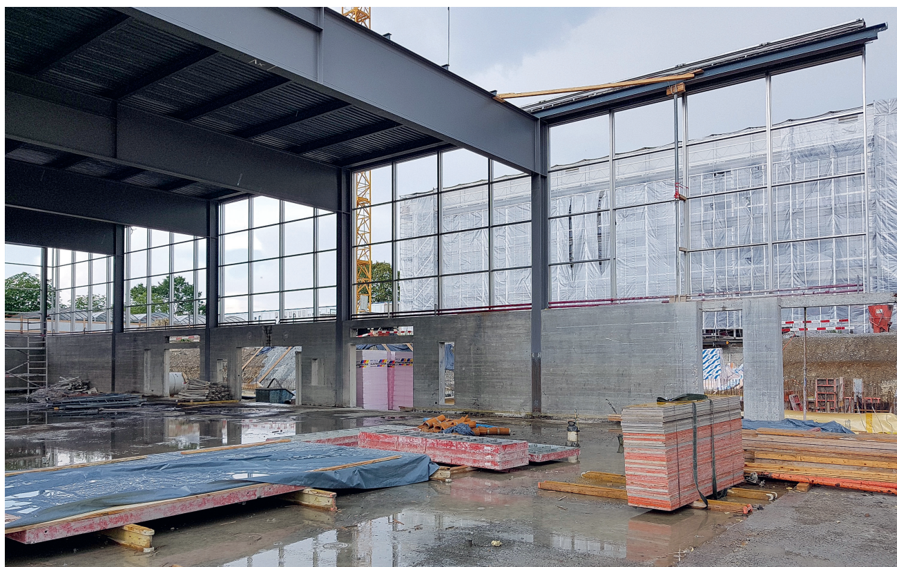
Die Sporthalle wurde um eine Hauptachse zu einer Dreifachturnhalle erweitert. Der hinzugekommene, biegesteife Rahmen wurde konstruktiv gleich ausgebildet wie die bestehenden Rahmenquerschnitte.
