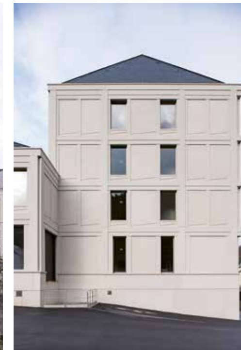
Südliche Stirnseite des Gebäudes. Wie ein Fries treten die „Taktstriche“ des Künstlers Peter Suter plastisch aus den Brüstungen der Obergeschosse hervor und laufen um die Fassade.
